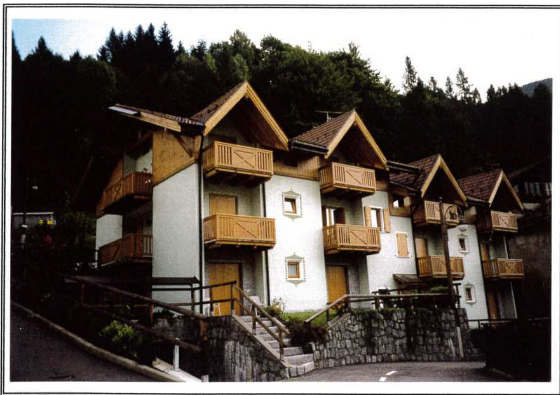
Edici a schiera realizzati con eccessivi movimenti di falda
