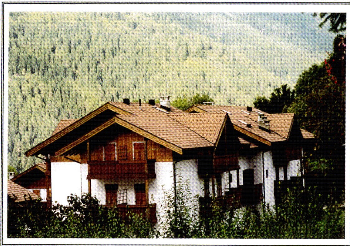
Edifici a schiera realizzati con eccessivi movimenti di falda
