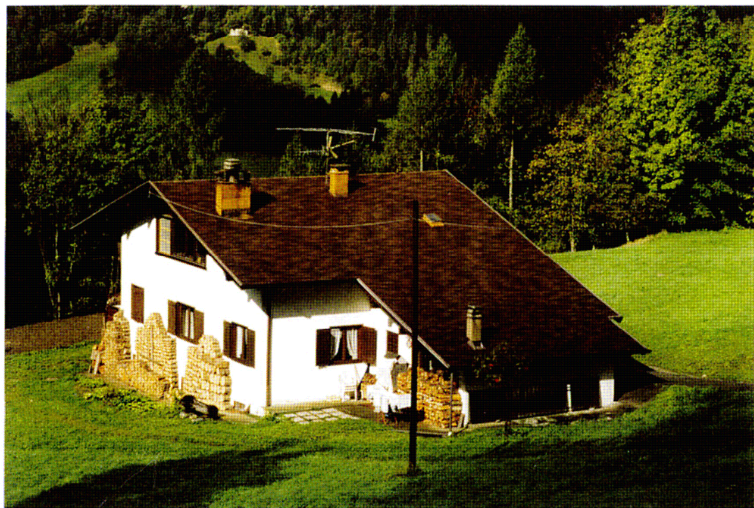
Pendenze delle falde e manti di copertura non corretti
