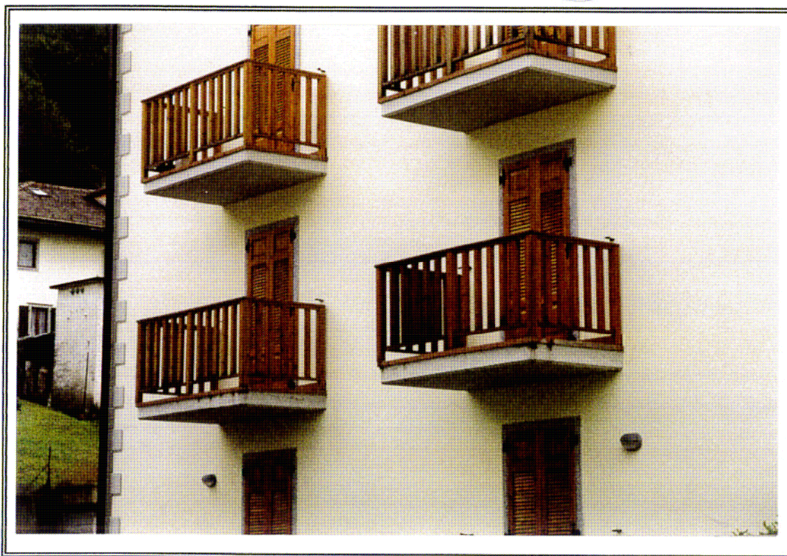
Balconi realizzati correttamente (interamente in legno) e scorrettamente (parzialmente in legno)
