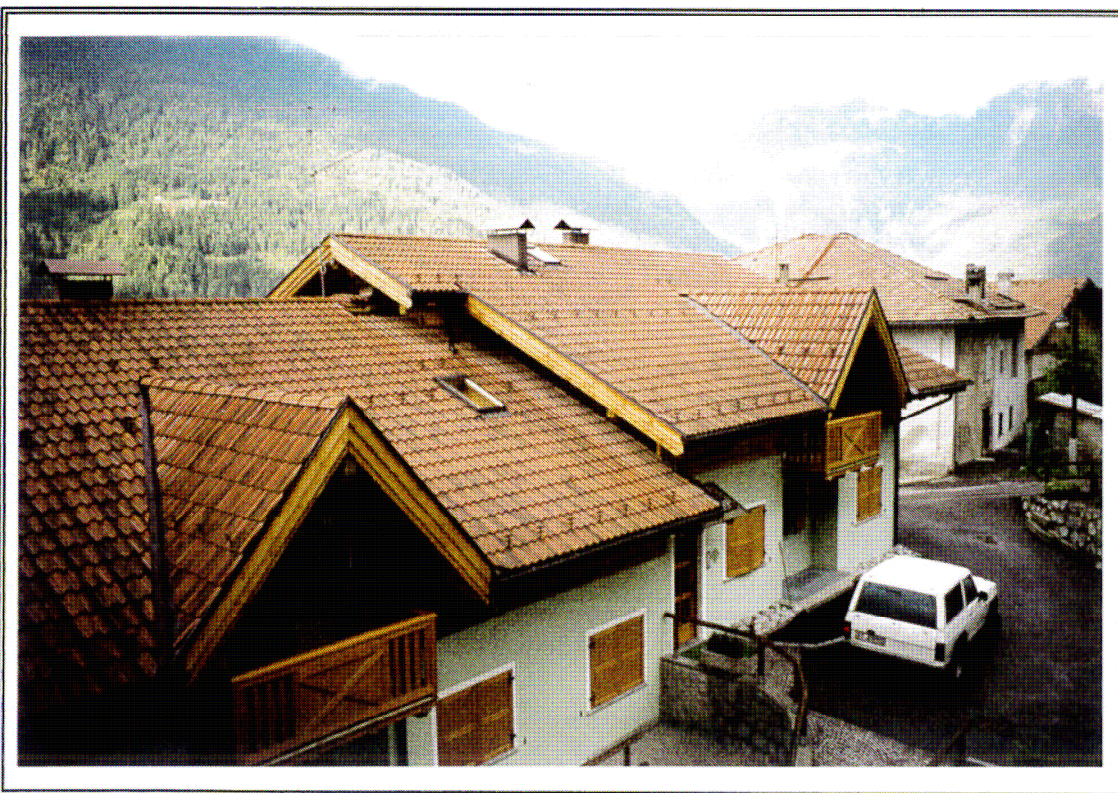
Edifici a schiera realizzati con eccessivi movimenti di falda
