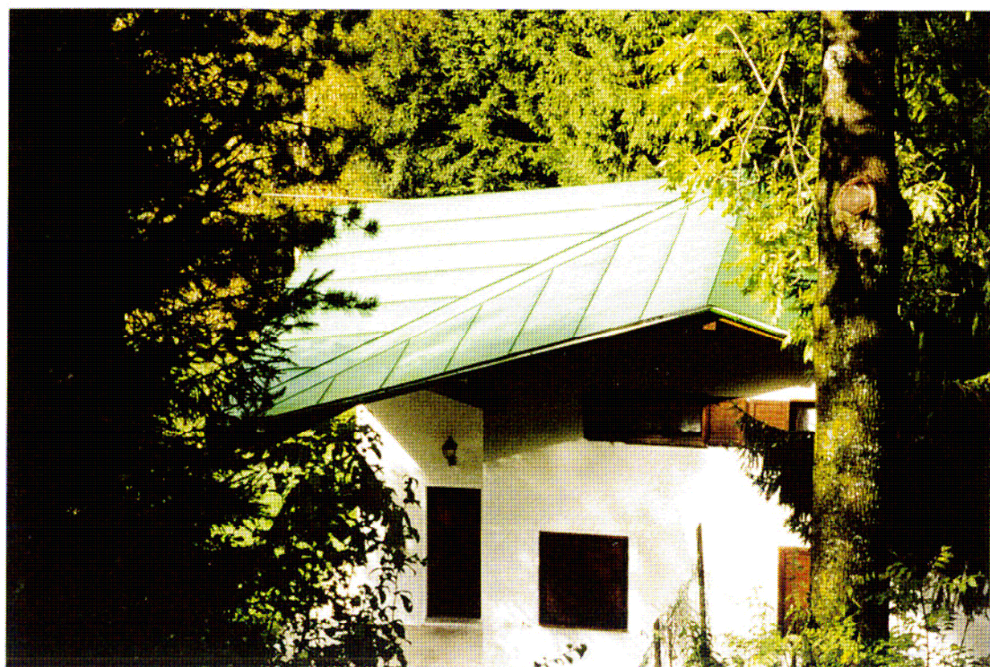
Pendenze delle falde e manti di copertura non corretti
