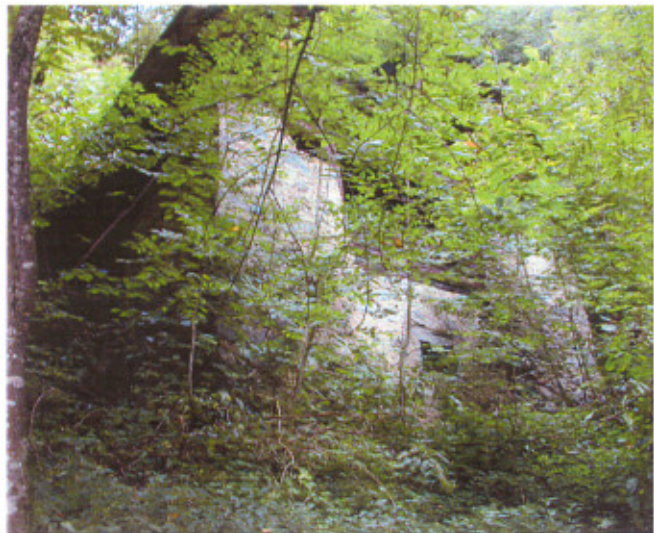
EDIFICIO 74 - LOCALITA' ROVINA
