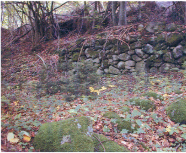
EDIFICIO 64 - RUDERE IN LOC. LIGNARO
