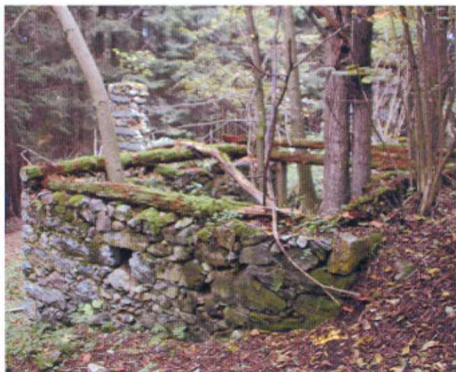
EDIFICIO 66 - LOCALITA' LIGNARO BASAMENTO "BLOCKBAU"
