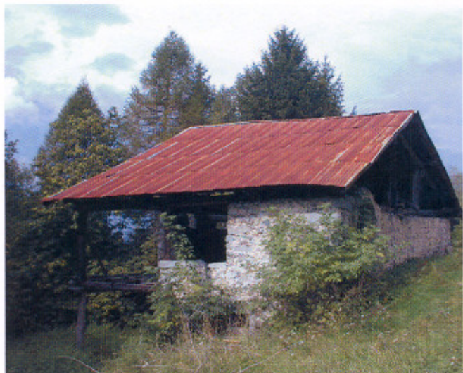
EDIFICIO 72 - LOCALITA' ROVINA
