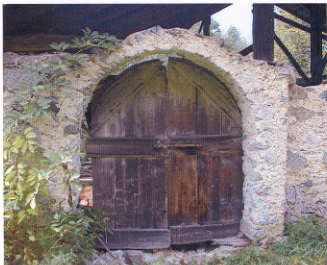
EDIFICIO 72 - LOCALITA' ROVINA
