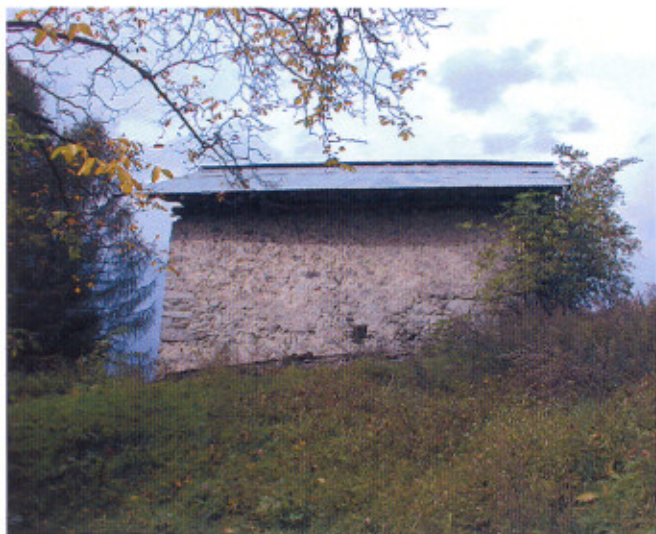
EDIFICIO 73 - LOCALITA' ROVINA
