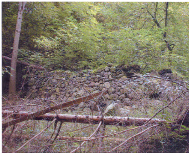
EDIFICIO 68 - LOCALITA' RUNG BASAMENTO "BLOCKBAU"
