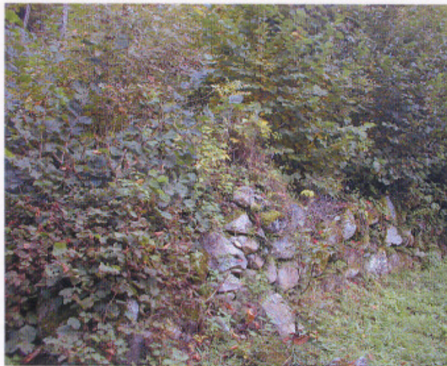
EDIFICIO 51 - LOCALITA' LIVERA BASAMENTO "BLOCKBAU"
