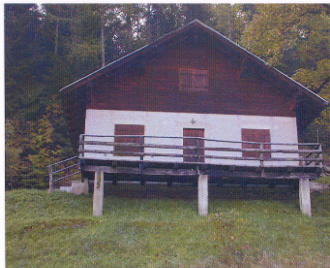
EDIFICIO 46 - LOCALITA' RONC
