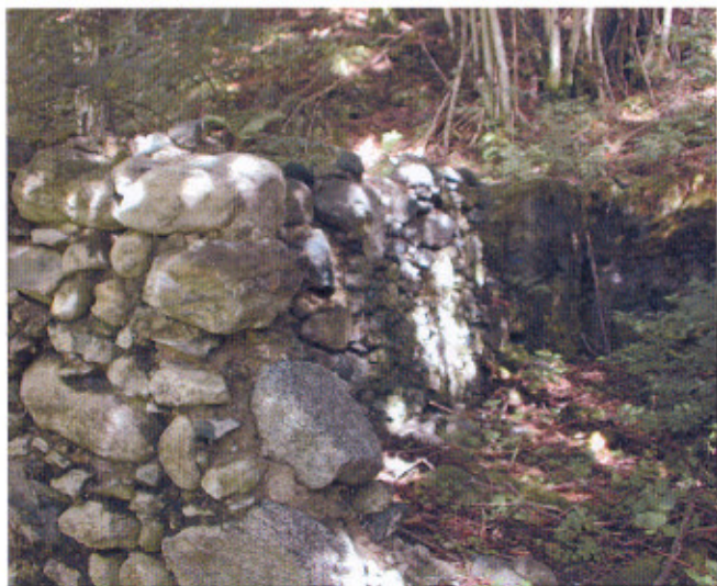
EDIFICIO 43 - RUDERE IN LOCALITA' CASELLA
