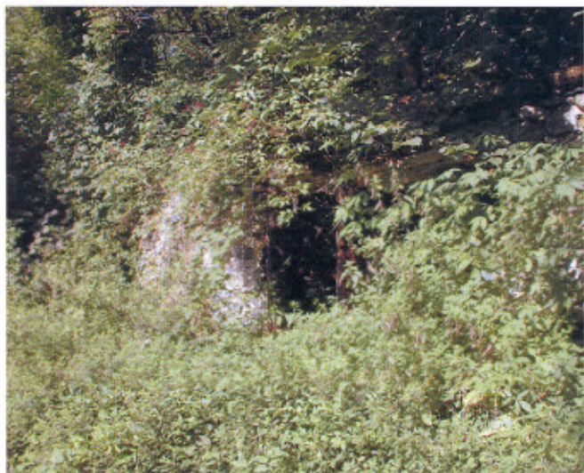
EDIFICIO 45 - LOCALITA' CASELLA BASAMENTO "BLOCKBAU"
