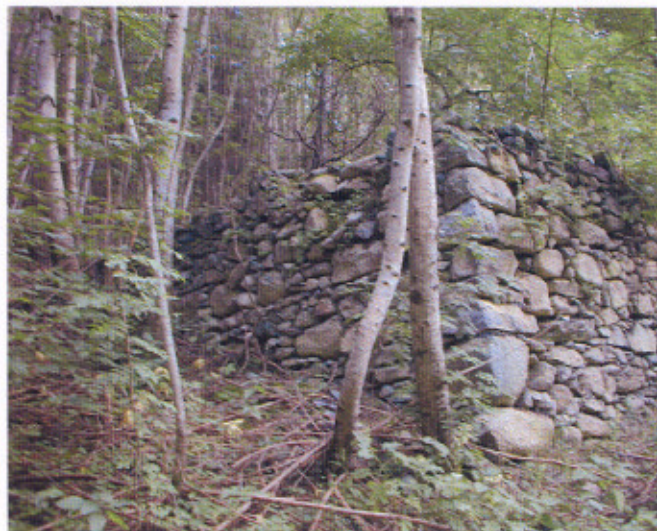
EDIFICIO 44 - LOCALITA' CASELLA BASAMENTO "BLOCKBAU"
