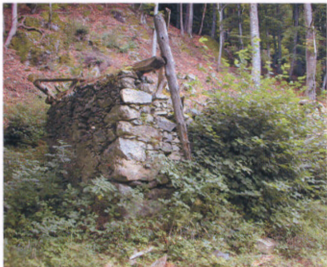
EDIFICIO 22 - LOCALITA' AMPOME' BASAMENTO "BLOCKBAU"
