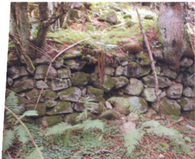
EDIFICIO 9 - RUDERE IN LOCALITA' CASACCI
