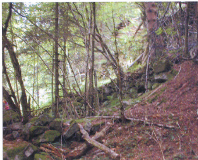
EDIFICIO 10 - RUDERE IN LOCALITA' CASACCI
