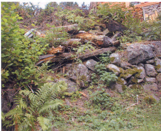
EDIFICIO 12 - LOCALITA' CASACCI BASAMENTO "BLOCKBAU"
